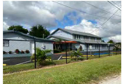
Iglesia De Dios Pentecostal, 10801 SW 184th St (1959)
